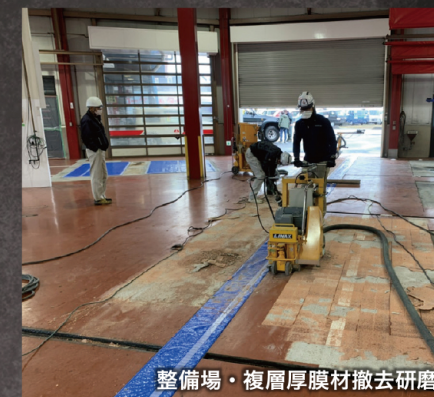
公共施設・防塵塗膜研削研磨
